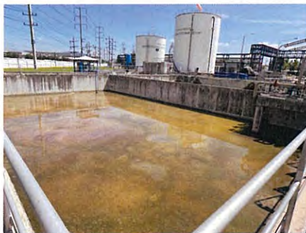
ภาพที่ 2-17 บ่อพักน้ำหล่อเย็น กรณีฉุกเฉิน
