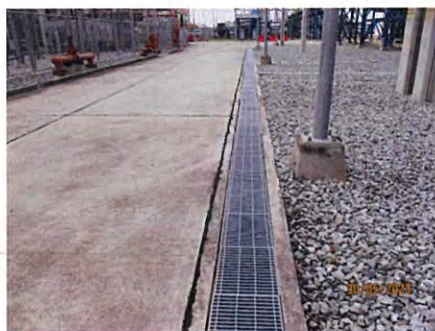
ภาพที่ 2-28 รางระบายน้ำฝนในพื้นที่โครงการ
