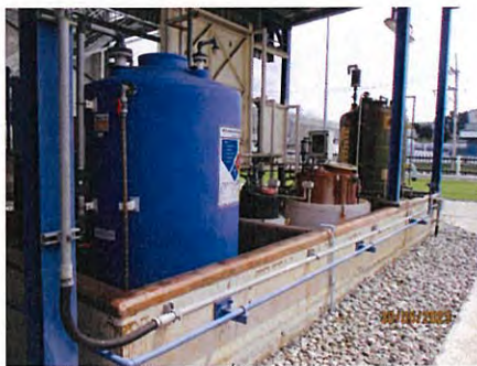
ภาพที่ 2-56 คันกั้นสารเคมีทกรั่วไหล
