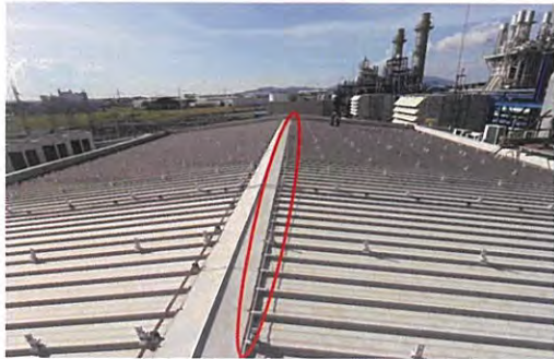
ภาพที่ 2-64 สาย Life Line บริเวณหลังคาอาคาร
