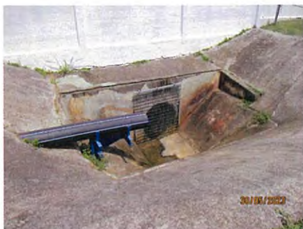
ภาพที่ 2-25 จุดระบายน้ำฝนที่เชื่อมต่อกับระบบระบายน้ำฝน ของนิคมฯ
