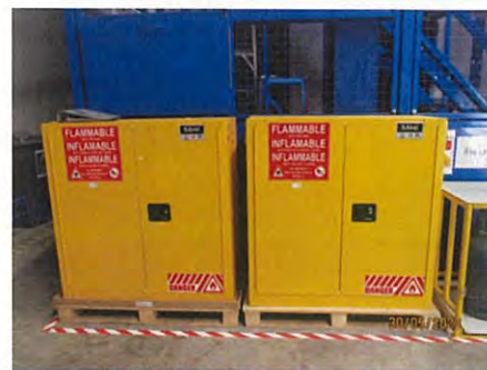
ตู้เก็บวัตถุไวไฟในอาคารจัดเก็บวัสดุ
