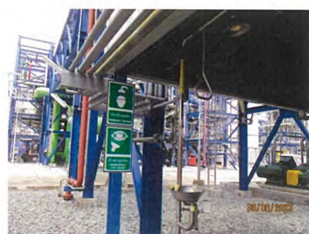
ภาพที่ 2-54 ฝักบัวชำระล้างร่างกายและที่ล้างตา (Safety Shower & Eye Washer)
