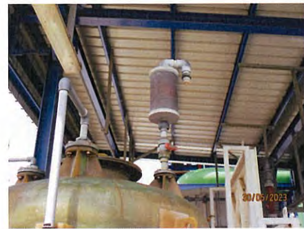
ภาพที่ 2-57 Activated carbon บริเวณถังเก็บสารเคมี
