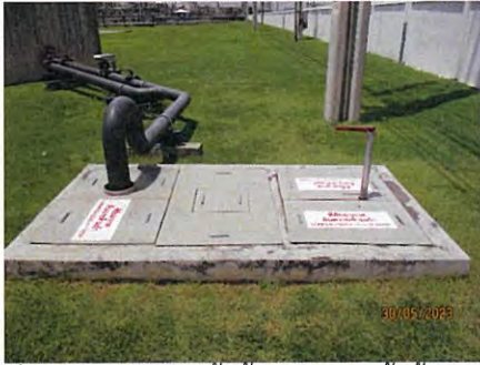
ภาพที่ 2-11 จุดระบายน้ำทิ้งจากบ่อพักน้ำทิ้งรวมไปยังระบบบำบัดน้ำเสียส่วนกลางของนิคมฯ
