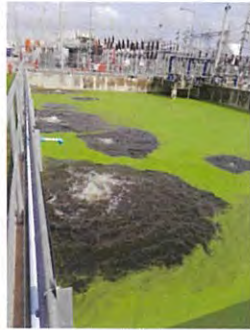
ภาพที่ 2-19 เครื่องเติมอากาศ
