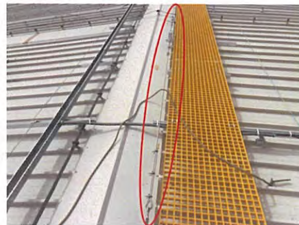
ภาพที่ 2-64 สาย Life Line บริเวณหลังคาอาคาร
